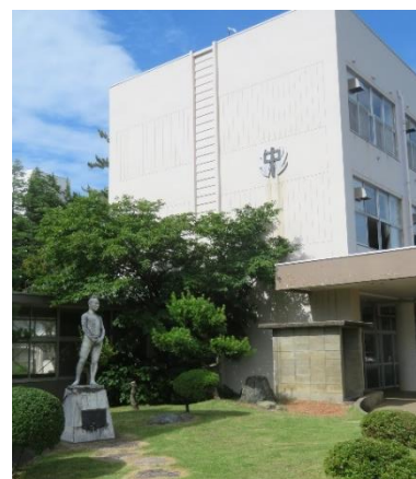
さわやかなあいさつが交わされる生徒玄関前より撮影
